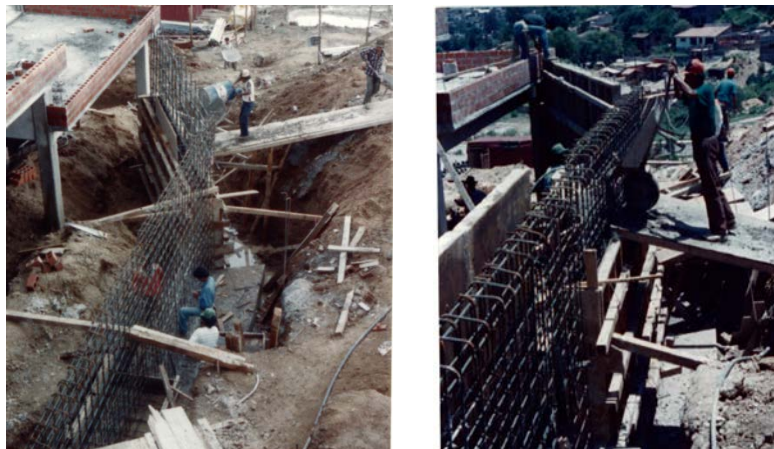
Figura 1.8 Ejemplo de Muros de Contención
