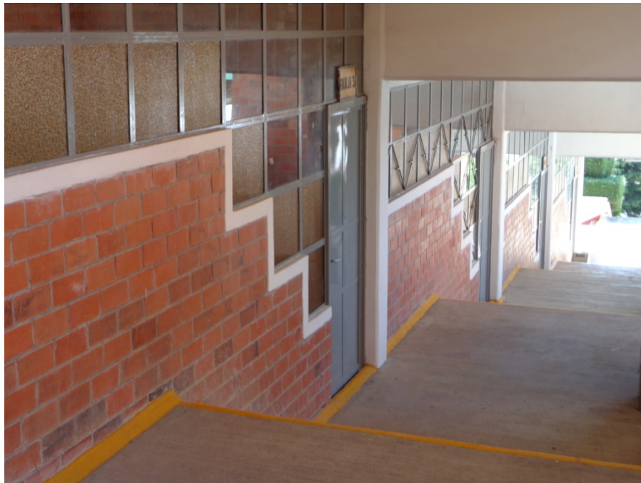
Figura 3.13. Fachada principal zona de aulas
