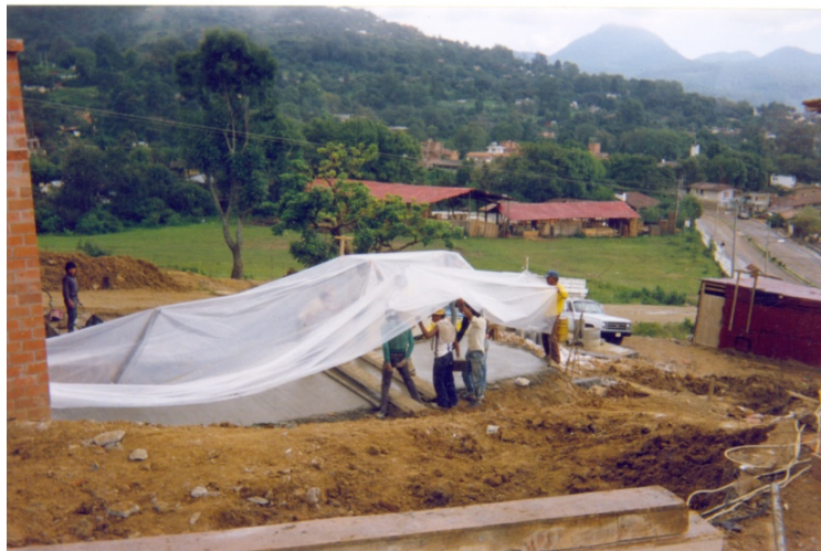
Figura 1.10 Colocación de cubiertas para colados en lluvia.
