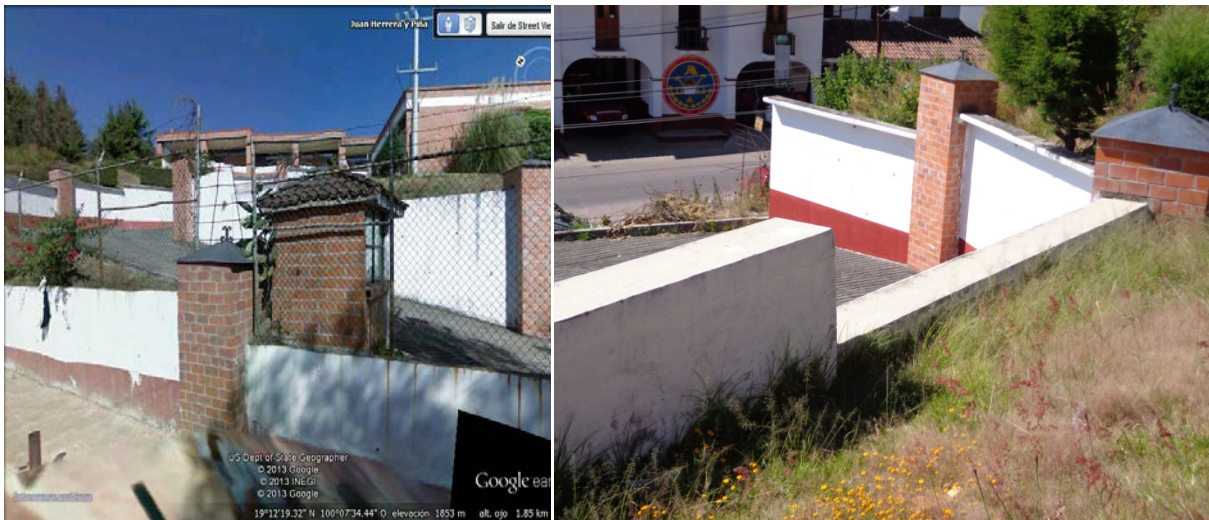
Figura 3.11 Vista de columnas de tabique, capuchones de herrería y aplicación de pintura vinílica blanca en muros.
