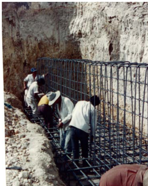
Figura 1.6 Armado del Muro de Contención Eje V
