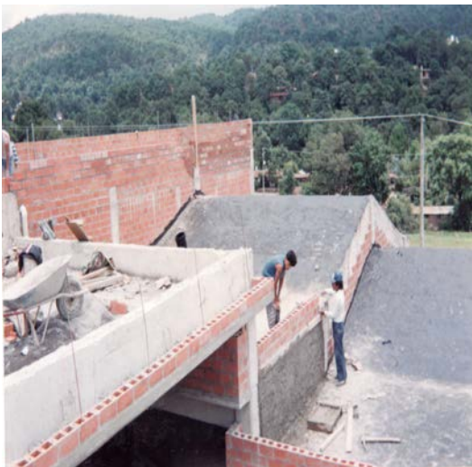
Figura 3.8 Colocación de teja en losa de azotea.
