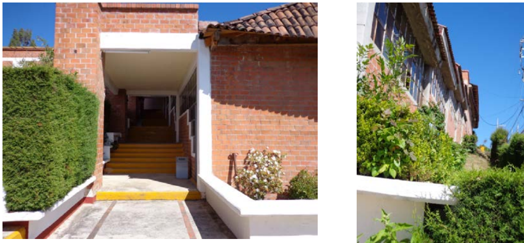
Figura 3.9. Fachada muro cabecero y posterior de zona de aulas.
