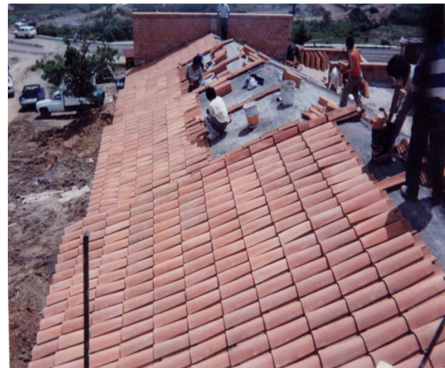
Figura 3.8 Colocación de teja en losa de azotea.
