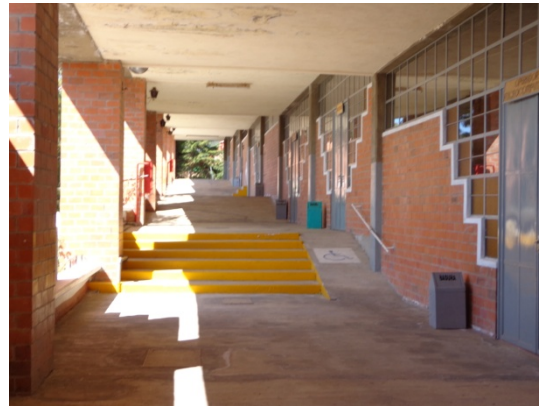
Figura 3.12. Vista de la celosía, faldón, muros de forma caprichosa fachada en talleres, columnas revestidas de muro de tabique y aplicación de pintura vinílica blanca en muros.
