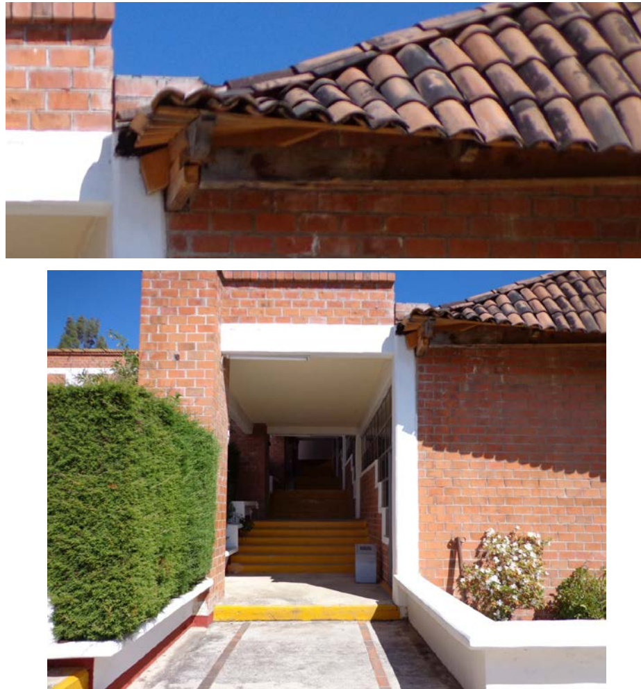
Figura 3.7 Colocación de vigas de madera y teja en zona de aulas.
