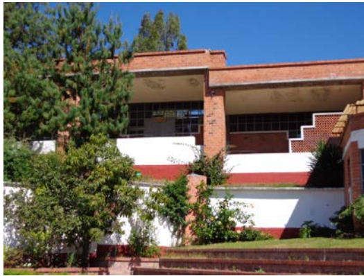
Figura 3.12. Vista de la celosía, faldón, muros de forma caprichosa fachada en talleres, columnas revestidas de muro de tabique y aplicación de pintura vinílica blanca en muros.
