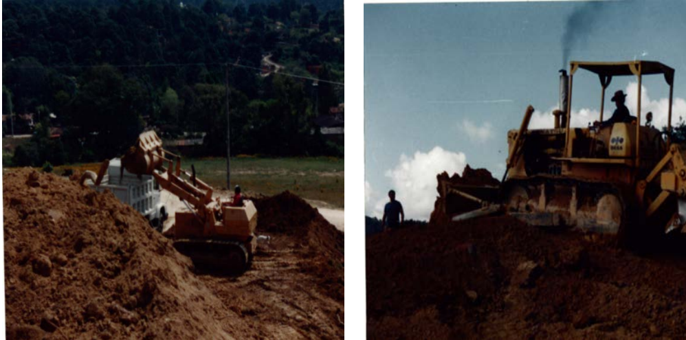
Figura 1.9. Movimiento de tierra para suavizar pendiente de talud.
