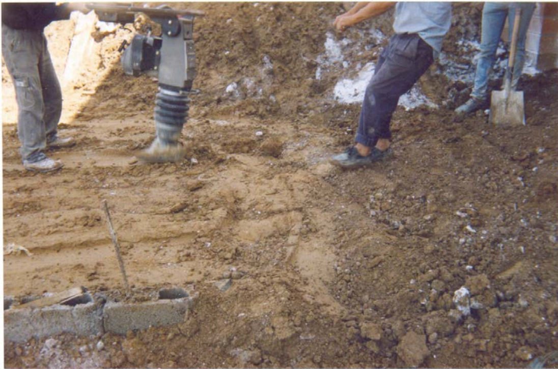
Figura 1.5. Trabajos de Mejora de terreno a base de riego de calhidra, aplicación de aditivos y colocación de material seco y de tepetate compactado al 95%.
